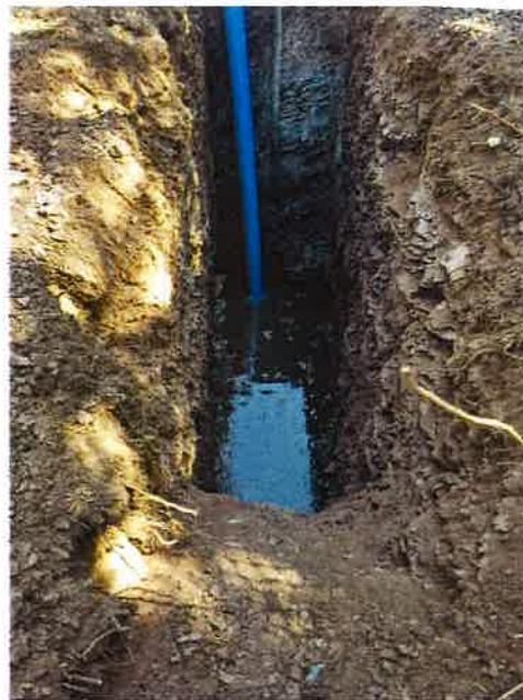
Slika 10. Stanje boje u raskopu na dan 21.03.
