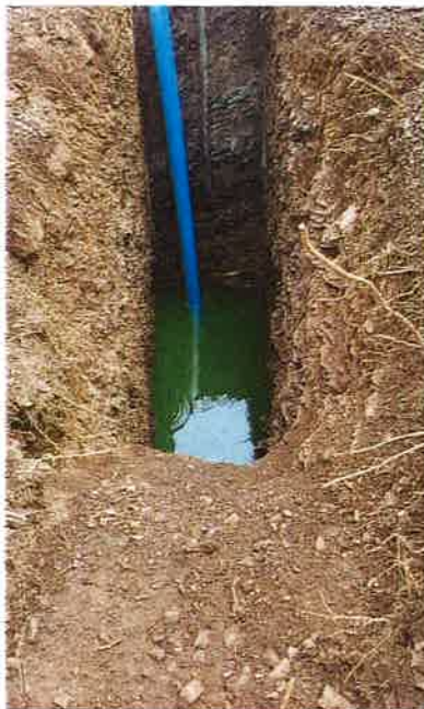
Slika 9. Stanje boje u raskopu na dan 18.03.
