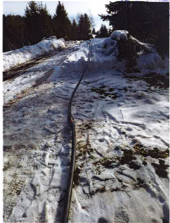
Slika 6. Izgled ulivne cijevi u raskop i cjevovoda za dopremanje vode
