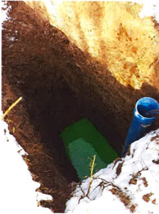
Slika 6. Izgled ulivne cijevi u raskop i cjevovoda za dopremanje vode
