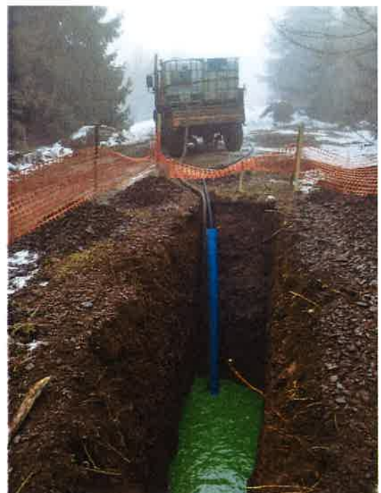
Slika 8. Stanje boje u raskopu na dan 17.03.
