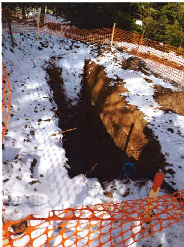
Slika 1. Izgled kopanog raskopa R-1 za opit bojenja
